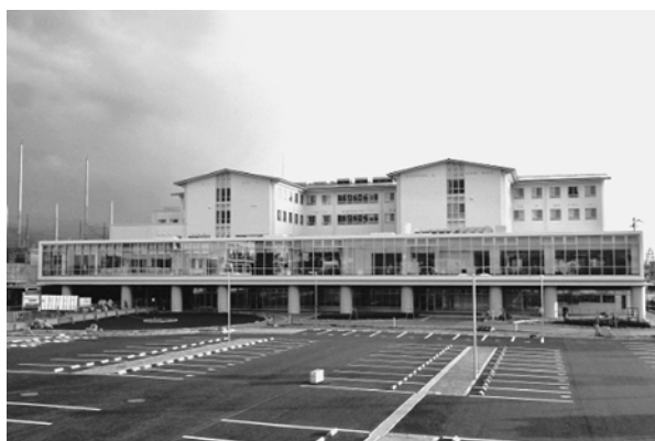
【新・市立奈良病院の様子】
